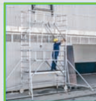
Diagonalstivere forbindes med stilladsrammen.
