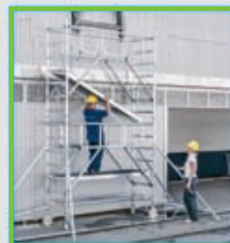
Næste platform monteres fra et sikkert ståsted.
