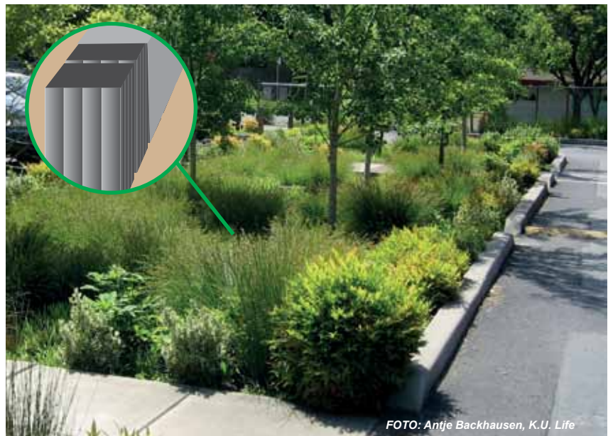
Regnbæde udført som plantebed og tilsluttet BIO-BLOK® faskine.
