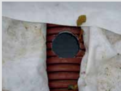
Forslag til eksempel på forstærkning af siderne med plastarmeringsnet EXPO 1211 Std.
