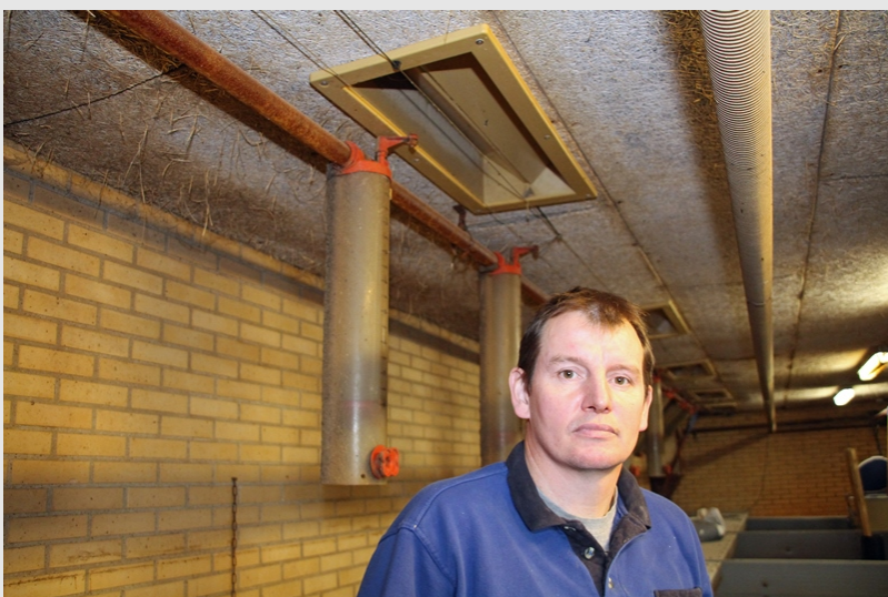
Henrik Svendsen foran ventilen i Direct Air løsningen
