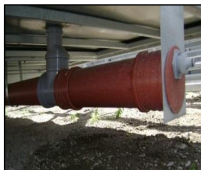
Fælles fløbsrør til tank eller anden Beholder.
