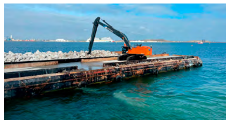
Hitachi ZX890LCH-7 har en gravedybde på 16 meter og en rækkevidde på 22 meter.
